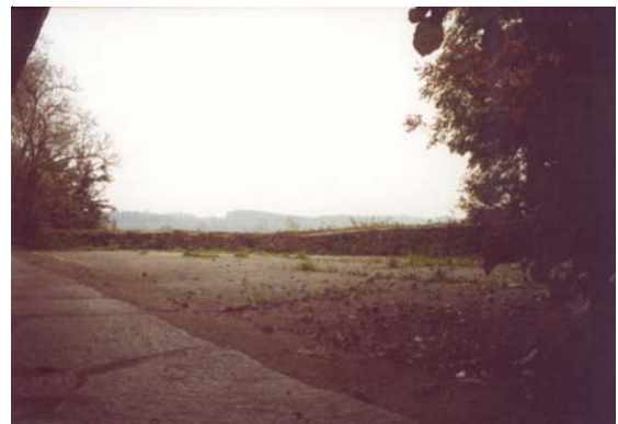
Abbildung 48: Terrasse vor Kioskgebäude (09.10.2002)
