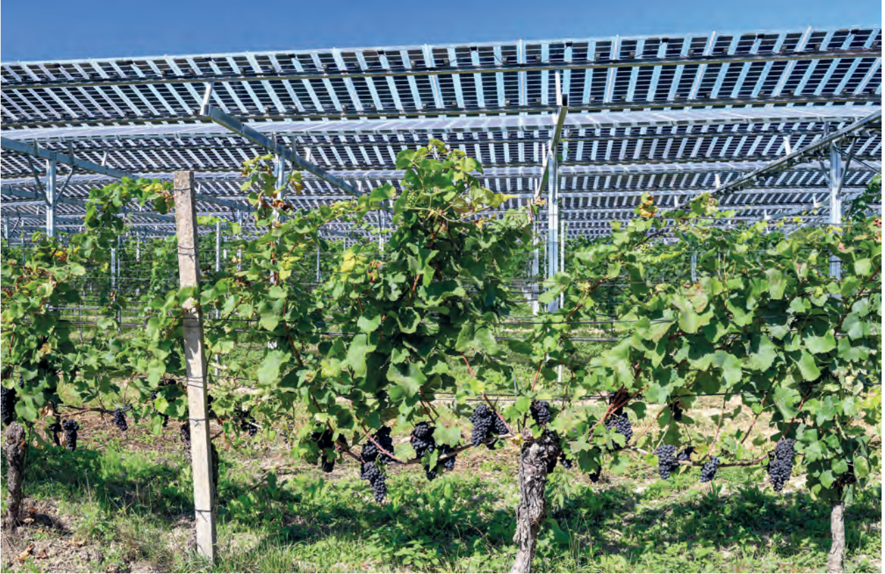
Weinanbau unter transparenten Photovoltaikmodulen
